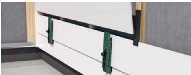
3. Dołożyć kolejną deskę HardiePlank®
