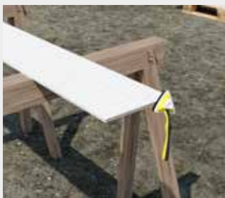
Aplikacja zabezpieczenia krawędzi ColourPlus™ przed montażem.
