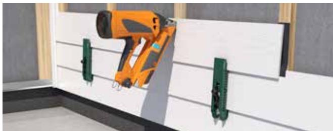
4. Mocowanie za pomocą gwoździ lub wkrętów (bez nawiercania wstępnego)
