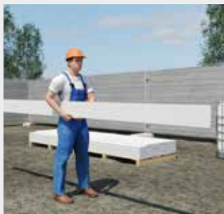
Deski HardiePlank® należy zawsze przenosić w trakcie montażu w pozycji „na sztorc”.
